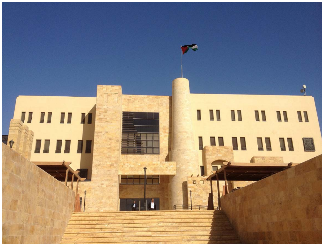
Centre d'Excellence d'Aqaba
